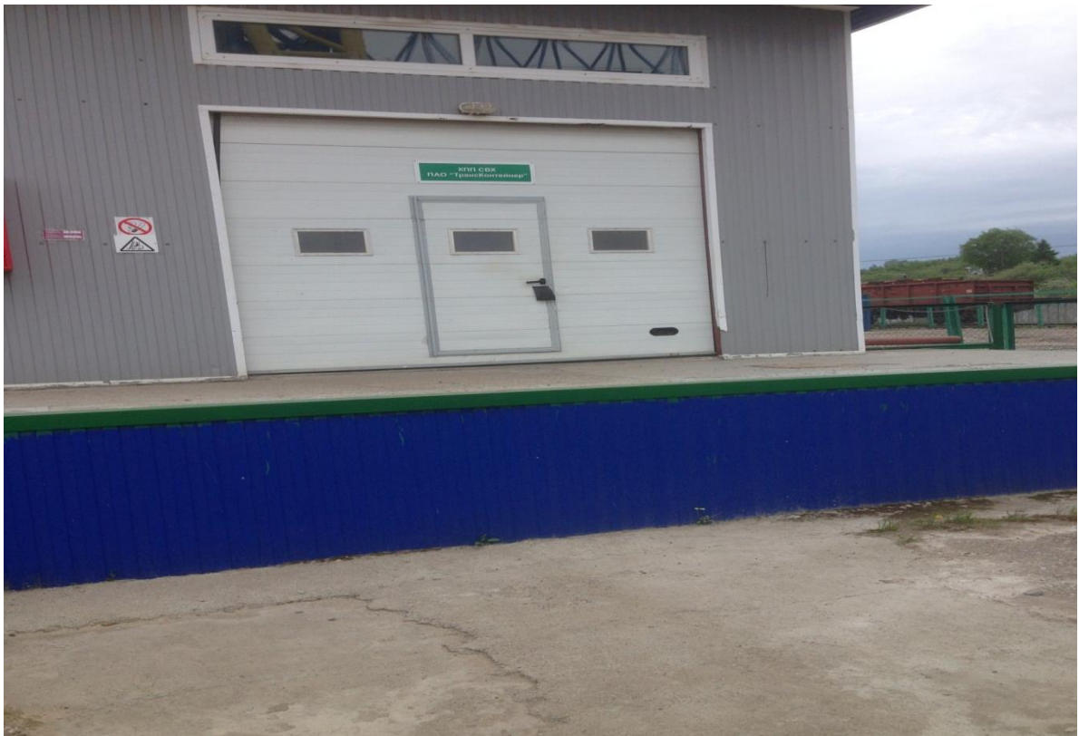
Контрольно-пропускной пункт склада временного хранения
