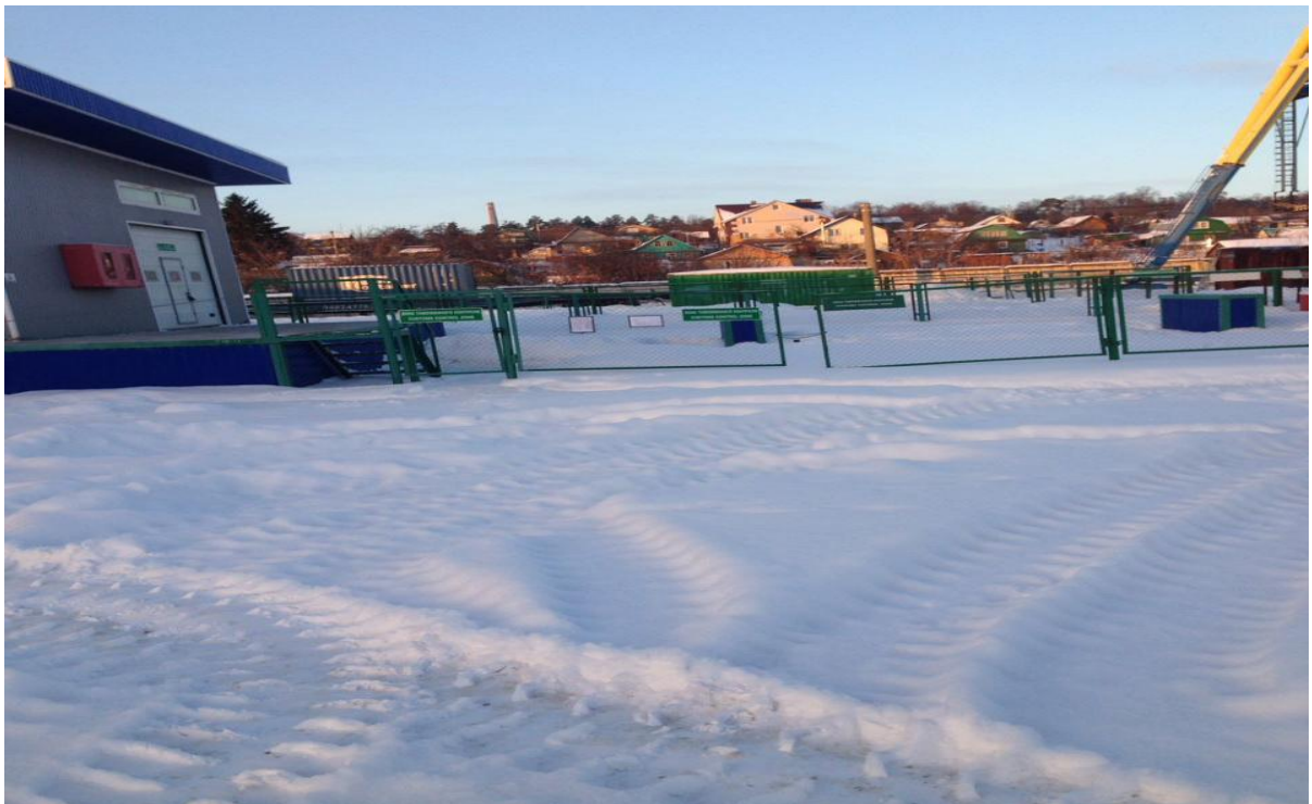
Въезд на Контрольно-пропускной пункт склада временного хранения
